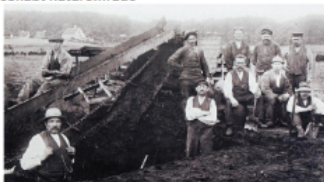
Tørvegravning ved Stenholt under 2. verdenskrig. Foto Esum Sø, Niels Richter-Fris
